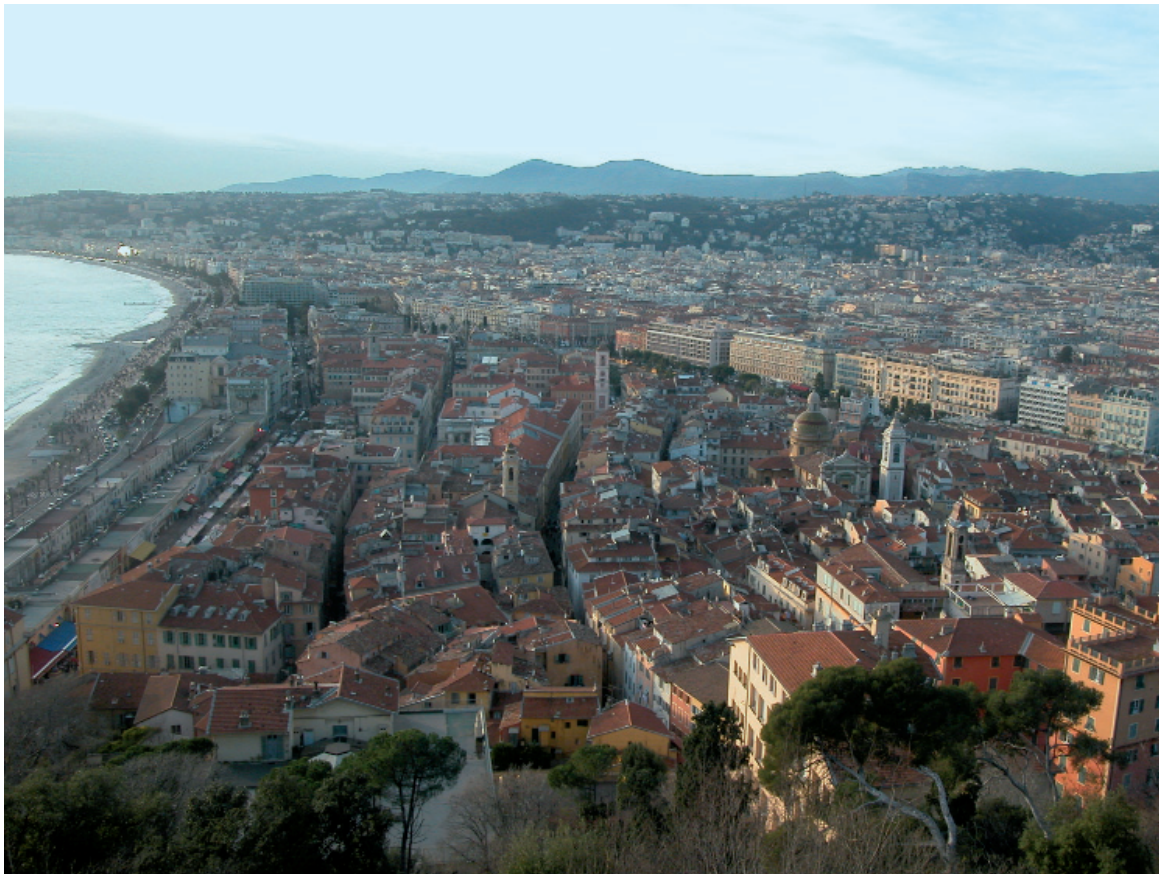
A cause de son bâti ancien, le vieux-Nice subirait de lourds dégâts en cas de séisme.
