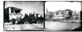
Photographie prises sur la Côte Ligure (A, Menton; B, Diano Marina) après le séisme de 1887 (Photos fournies par A. Laurenti).
